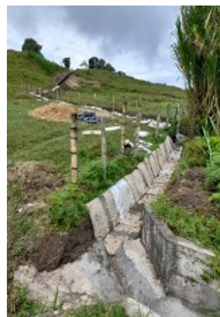
Construcción de canal flexible
